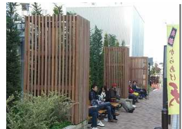
格子はイペ 12×40 使用 イペは反り振じれが殆ど無い素材なので縦のラインが美しい。
