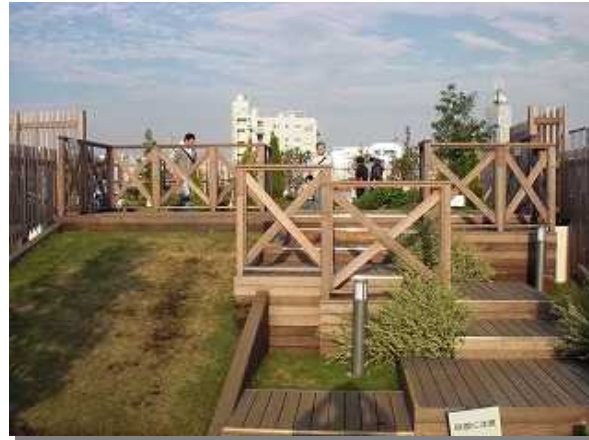
支柱:グリーンハート70×70 化粧クロス:20×90、手の触れるところにグリーンハートを使用した。この材に触るとしっとりしたろう状の感触がわかる。
