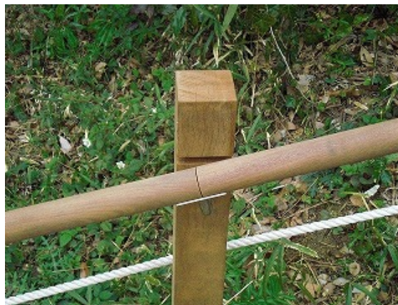
手摺:グリーンハートφ36 無垢材 受け金物:SUS製
