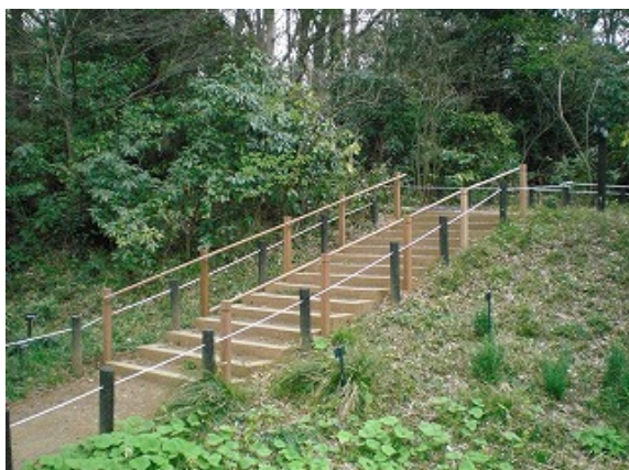
施工直後の階段、手摺
